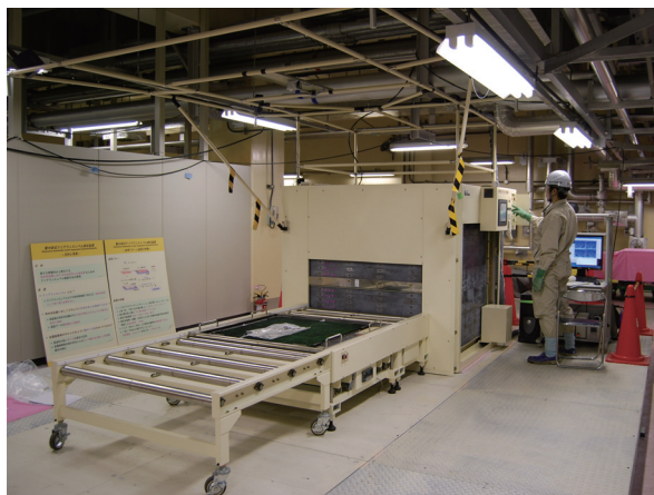
図2 東京電力柏崎刈羽原子力発電所における実証試験
