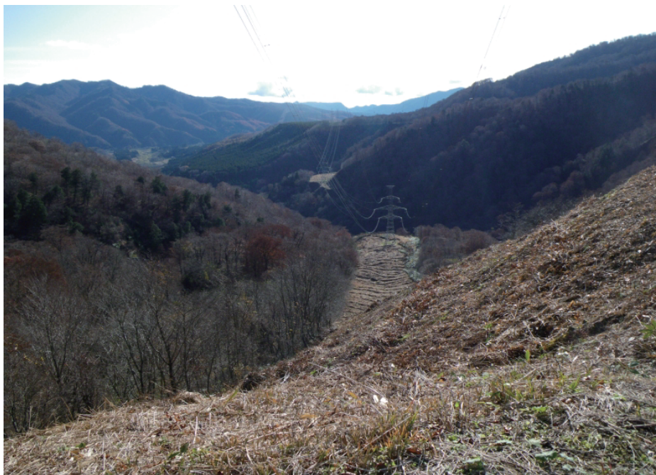
きれいに刈り払われた送電線下
