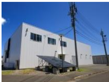
②配電需給協調実験設備
