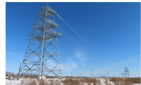
実規模送電線雪害試験設備※3
