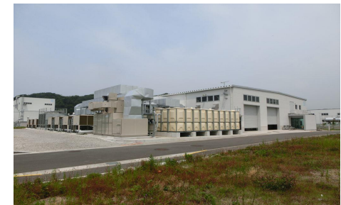
ヒートポンプ研究開発実験棟※2
