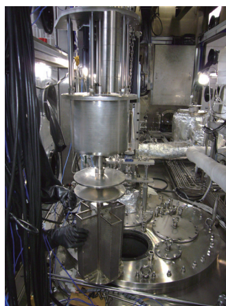
(電解精製装置)
