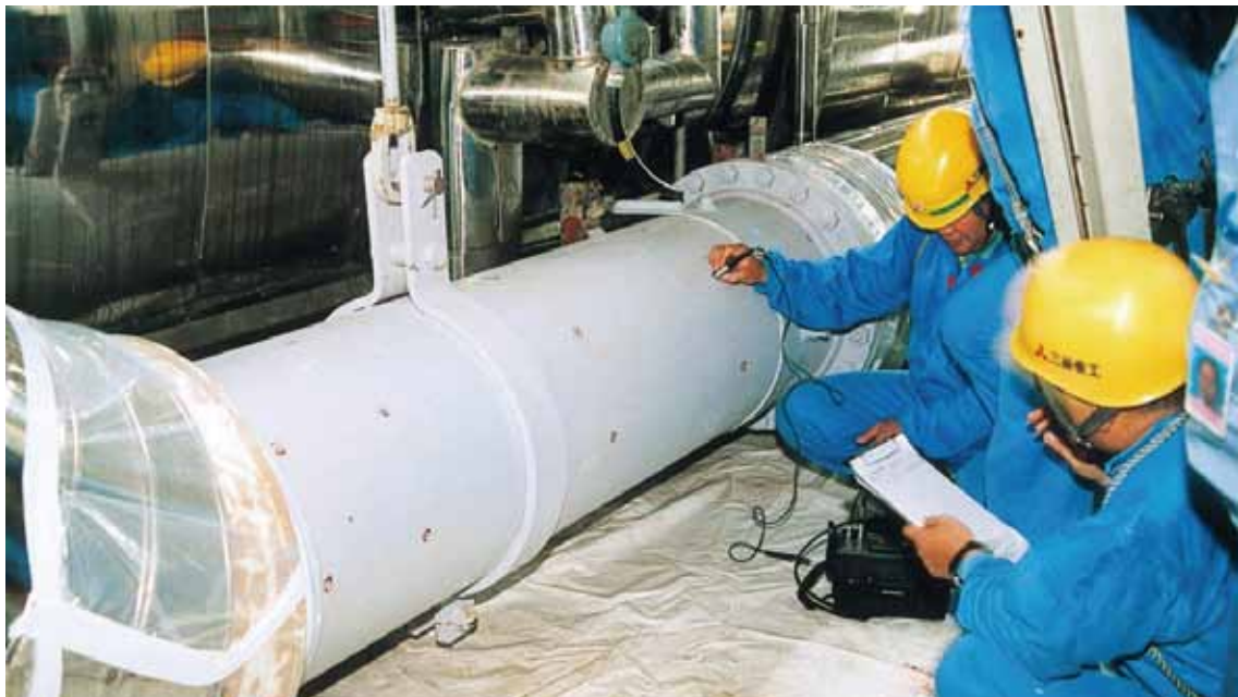
発電プラントの配管肉厚検査風景
