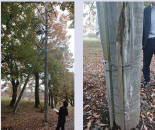
(a) 高経年化の進む電柱の例
