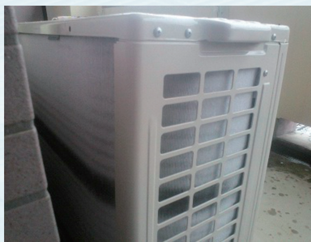
家庭用ヒートポンプ暖房運転時の 屋外機の着霜イメージ
