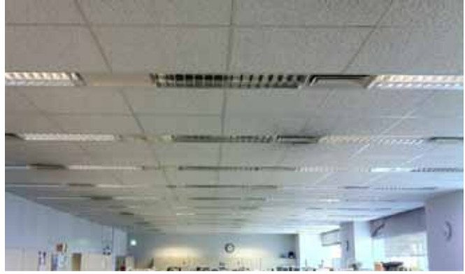
図 2 照明間引き後のオフィスの様子
