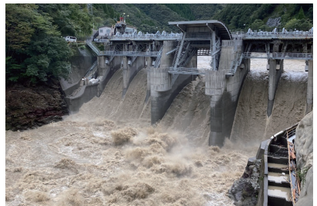
九州電力株式会社山須原ダム(耳川) における通砂運用の様子
